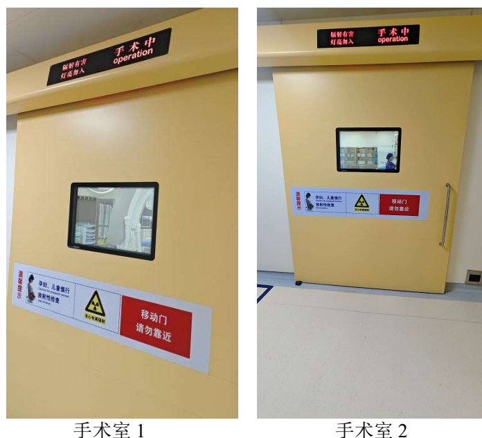
图 3-2 各机房内工作状态指示灯现场图
