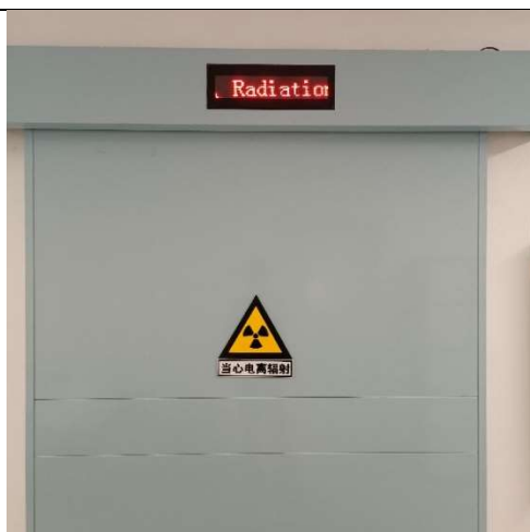
图 3-4 各治疗室内工作状态指示灯现场图
